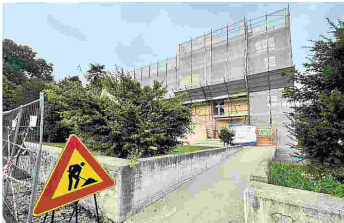
Il cantiere dell'ambulatorio, sopra la farmacia comunale di Intra
